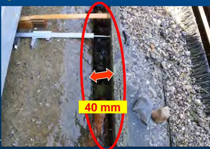
Spalte zwischen Rechen und Bauwerk
